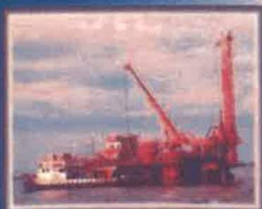
Operacion en Plataforma Tuberia Flexible en el Artico
