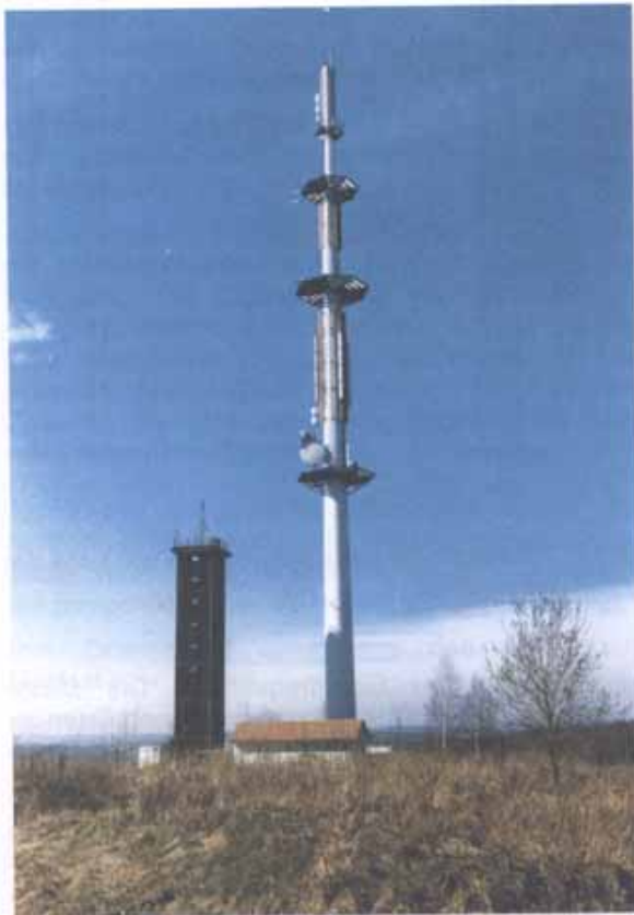
Bild 1 Stahlrohturm in Gera
